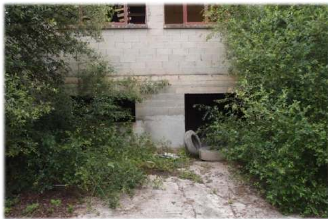
J2.6 – Constructions abandonnées en milieu rural
