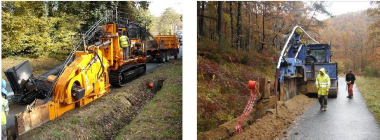
Figure 38 : Photos de trancheuse prises sur chantier
